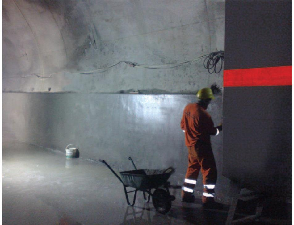
Plateforme et structure murale, le moule est réglable en hauteur et largeur en fonction du diamètre ou de la section du tunnel.
