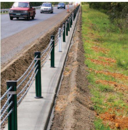
Pour la pose de barrières à cables, la technique du coffrage glissant avec la 5700C est la solution pour éviter le fauchage sous barrières.
