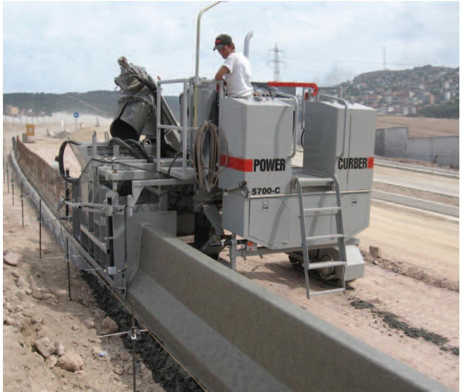
5700C avec moule barrière de sécurité en Turquie (Hauteur 855mm) et équipée de protections sur chenilles.
