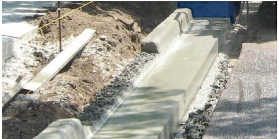
Le couteau guillotine réduit la perte de béton, mais la reprise manuelle reste toujours nécessaire.
