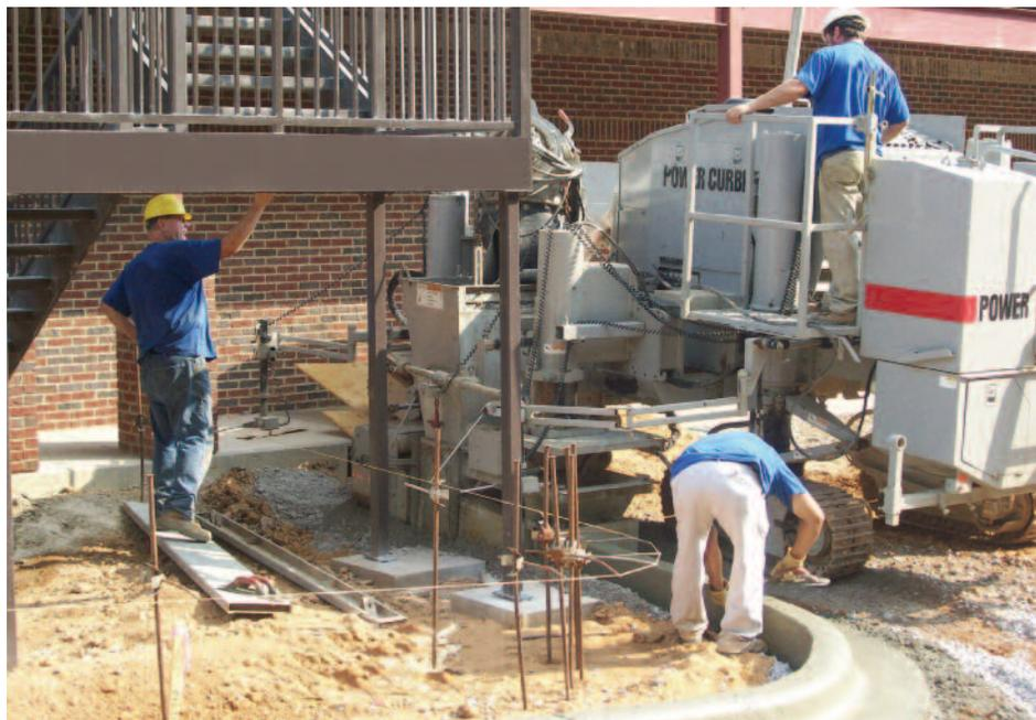
Machine en œuvre dans les rayons très serrés.
