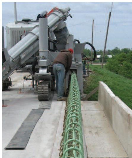
Pose de barrière sécurité sur armature métallique.
